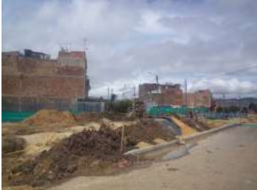
Imagen 7. Obra en ejecución
